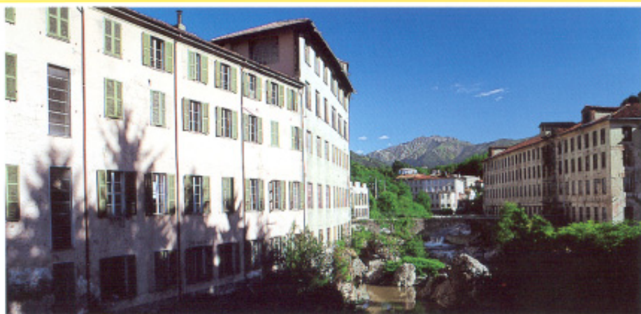
Antichi lanifici lungo il Torrente Cervo a Biella.
